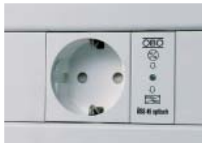
Šuko-utičnica i modul za zaštitu od prenapona
