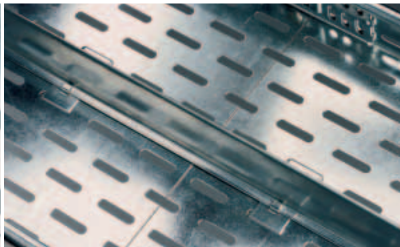
Fertig eingesetzter Trennsteg in einer MKS-Kabelrinne
