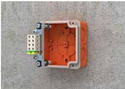
Anzeichnen, bohren, anschrauben, fertig – die zwei vormontierten Schraubanker sind gleichzeitig die Befestigung des Kabelabzweigkastens.
