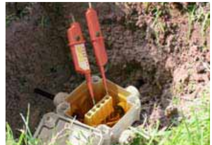
Aquasit ist selbstverschließend, so dass sich elektrische Verbindungen nach der Installation einfach prüfen lassen.
