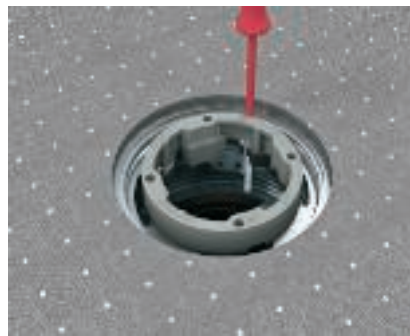
Telitank-Montage auf Unterflurauslass US80 und Unterflurdose UDL2-80 Den innenliegenden Montagering in den oberen Bereich des Auslasses drehen und durch Eindrehen der Spannschraube festsetzen. Der eingelegte Distanzring sollte etwa bündig mit der Oberkante Fertigfußboden liegen.
