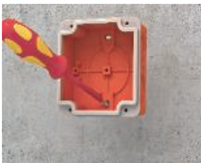
Montagevorbereitung Bodenöffnungen ausbrechen.
