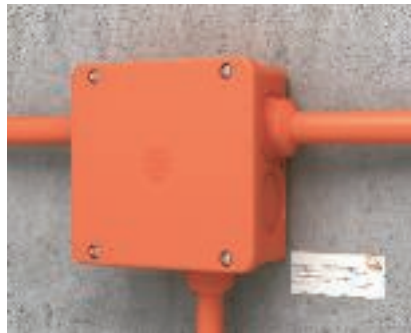
Anwendung FireBox B 160 E Wandmontage Abzweig Fertige Montage und Installation B 160 E mit Wandkennzeichnungsschild.
