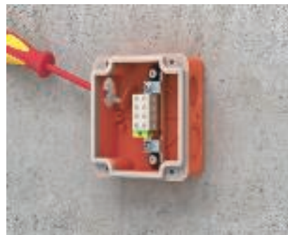
Installationsvorbereitung Einstecköffnungen ausbrechen.
