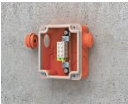
Installationsvorbereitung Einsteckdichtungen montieren.
