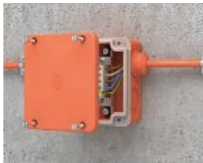
Abschluss Montage Deckel aufschrauben.
