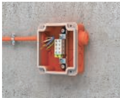
Installation einer Leitung Abisolierte Kabelenden einführen.
